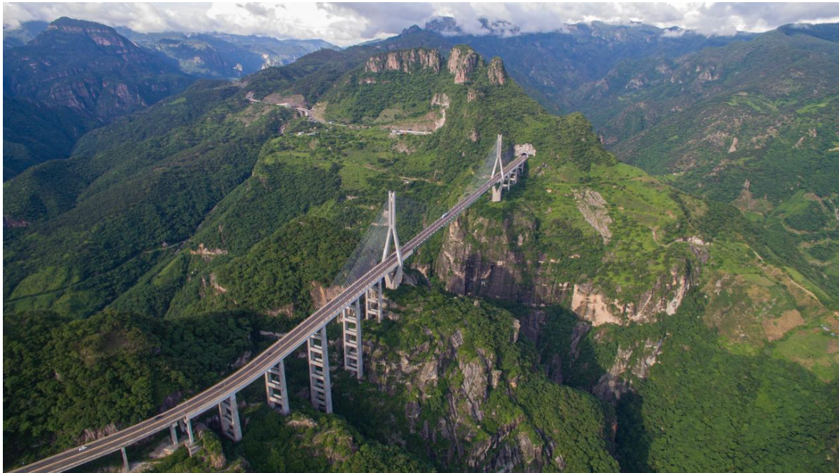
Panorámica del espectacular puente Baluarte enclavado en el macizo montañoso de la Sierra Madre Occidental. Acervo: Rocher Ingeniería.
