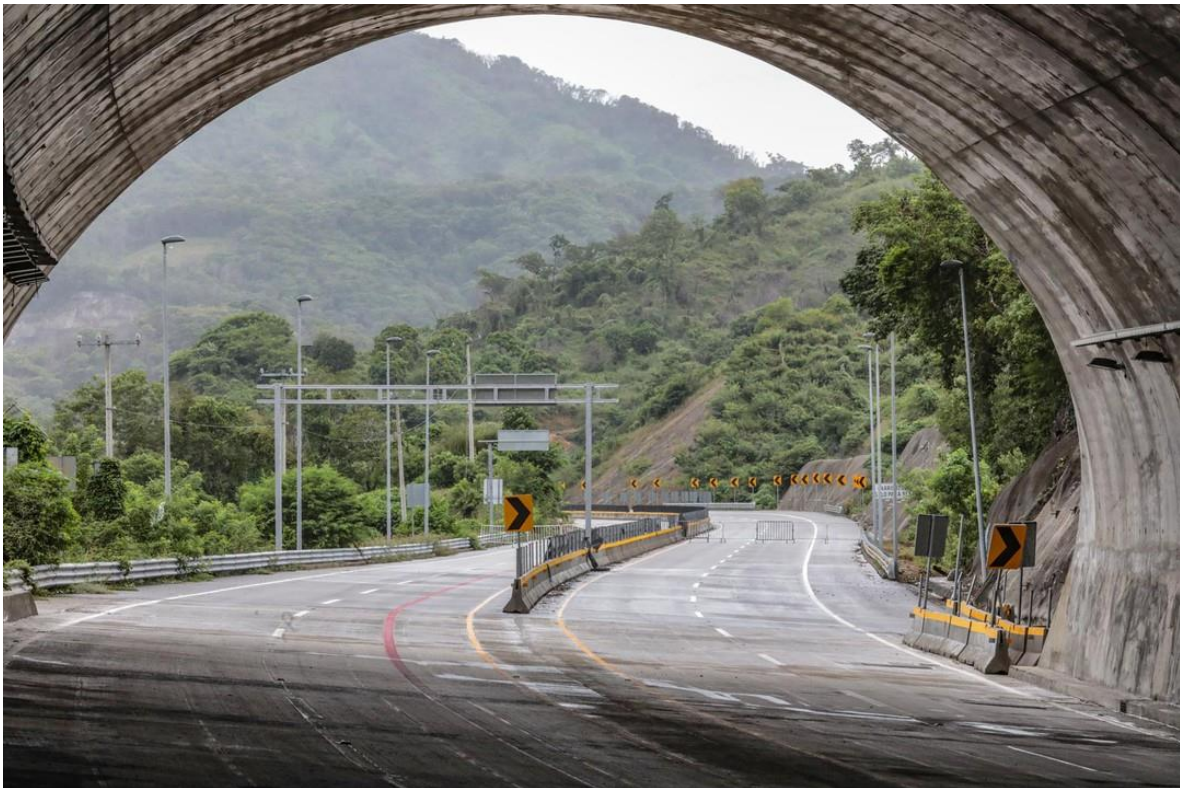
Libramiento Poniente de Acapulco, ya terminado, a la salida de uno de sus tres túneles. SICT
